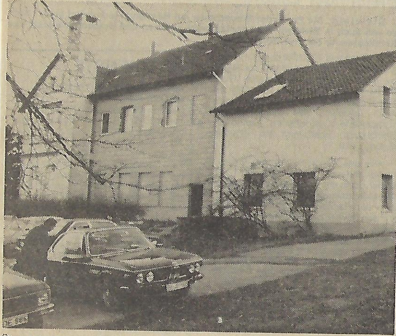
Über Jahre hinweg stand das Gebäude auf der Hünenburg leer und niemand kümmerte sich darum. Erst der Abrißbeschuß des Liegenschaftsausschusses machte die Kommunalpolitiker mobil.
