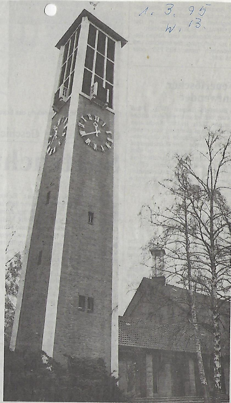
Wahrzeichen Quelles und »Finger Gottes« – der Turm der Johanneskirche bestimmt das Bild des Stadtbezirkes seit 39 Jahren. Falls er abgerissen wird – und vieles spricht dafür – soll er nach alten Plänen genauso wieder aufgebaut werden. Fotos: Steiner
