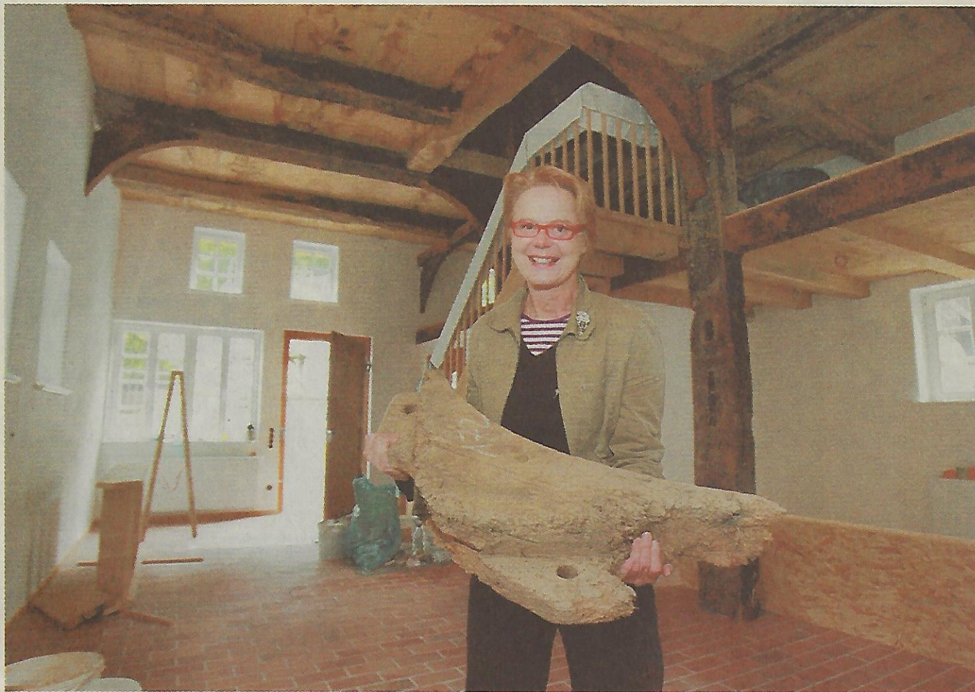
Großzügiger Seminarraum: Hier können Kinder alles lernen, was mit dem „System Hof“ zu tun hat. Museumsleiterin Rosa Rosinski freut sich über den gelungenen Aufbau und zeigt ein borkenkäfergeschädigtes hölzernes Verbindungselement, das ersetzt wurde. FOTOS: ANDREAS ZOBE
