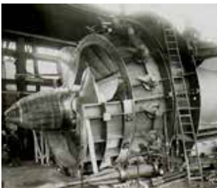
Turbinen für das Moselkraftwerk (Stadtarchiv, Foto: Freie Presse 1966)
