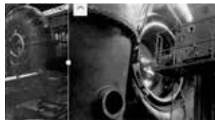
Freistrahlturbinen wurden für Anlagen mit wenig Wasser, aber besonders großer Höhe gebaut. In Norwegen betrug das Gefälle bis zu 350 m. Der Laufraddurchmesser betrug 3,50 m bis 4,20 m. (Foto: Wilhelm Krüger)
