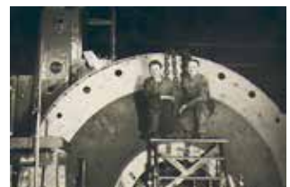
Ein Teil wird auf sein Bohrwerk aufgespannt, rechts Wilhelm Krüger. (Fotos: Wilhelm Krüger)
