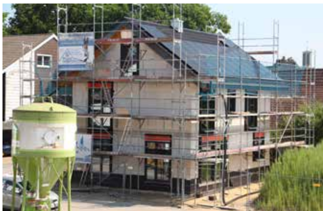
Diese Immobilie wurde exemplarisch im Rohbau vorgestellt und erläutert. (Fotos: U. Geisenhanslüke)
